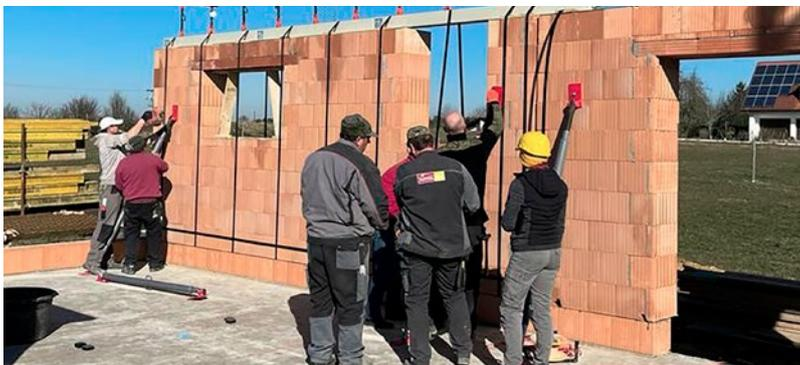
Ein genauer Ablauf- und Montageplan erspart Zeit und gibt die nötige Sicherheit für einen reibungslosen Ablauf. Praxisgerechte Komponenten wie Vario-Traverse, Kran-Traverse, Transportcontainer und Richtstützen garantieren ein sicheres, schnelles und unkompliziertes Handling. Unsere Kran-Traverse ist exakt auf die Vario-Traverse abgestimmt und dient somit als Justierelement bei der Montage unserer ZIEGEL-Wandelemente.
