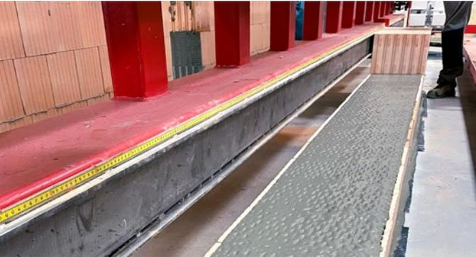
Die ZIEGEL-Wandelemente werden bis auf 3 cm Abstand aneinander gestellt und die Stoßfuge mit dem Mörtel der Lagerfuge ausgemörtelt.
